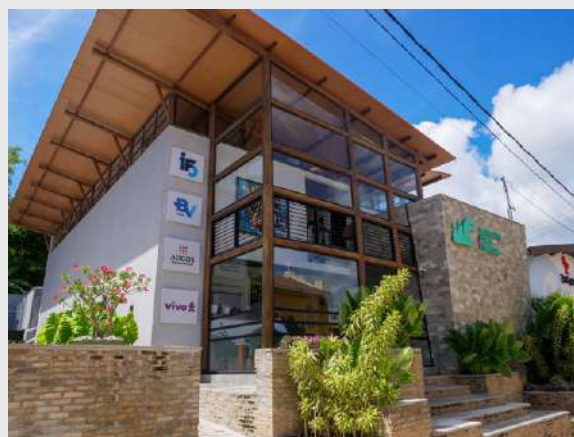
Fachada do Instituto Ítalo Ferreira, apoiado pelo BV
